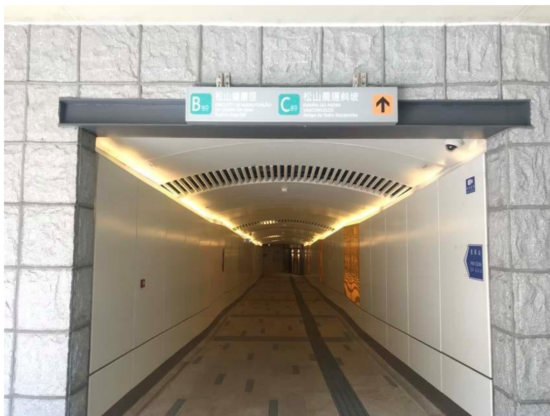
圖 1.5 沿隧道直行乘電梯按 2 字樓
